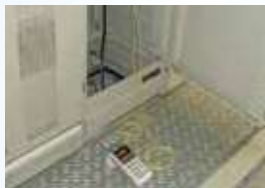
光ケーブルの ロス測定
